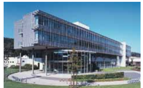
Verwaltungsgebäude SIEGENIA-AUBI, Wilsdorf.
